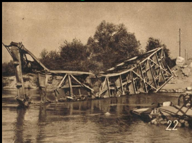
22. Železničný most v Humennom.
